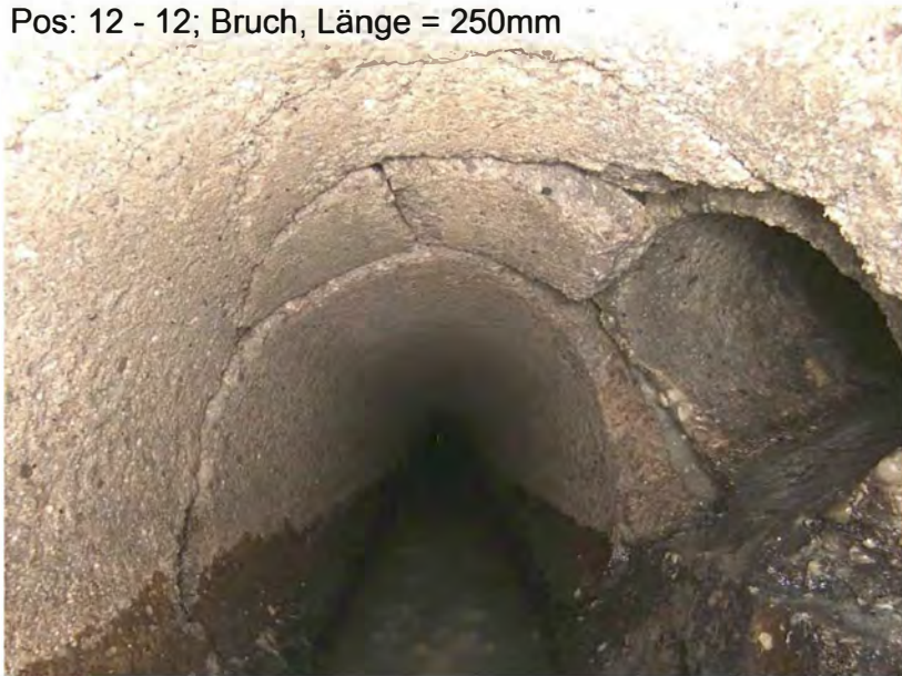
Kanal – Rohrbruch
